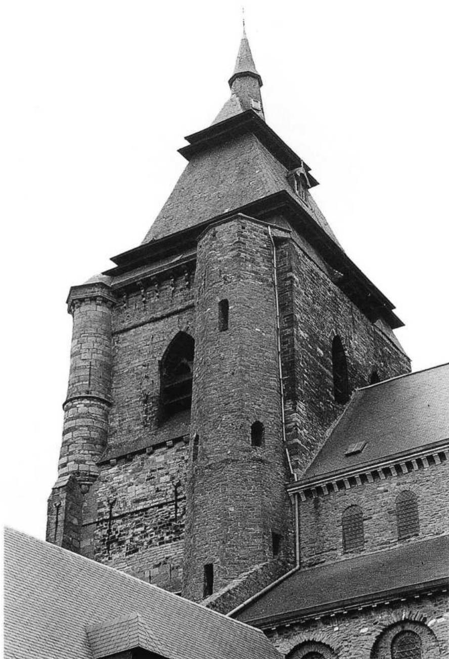
Fig. 1. Collégiale Saint-Vincent. Vue extérieure de la tour occidentale, notamment des ouïes de la chambre du carillon et des abat-sons de la toiture, à hauteur des cloches de volée.
