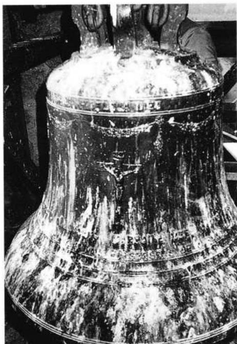
Fig. 3. Triste spectacle d'une cloche Legros. Les pigeons et les choucas nichent dans la tour, car les abat-sons ne sont pas réparés (Photo ZVS-Archiv).
