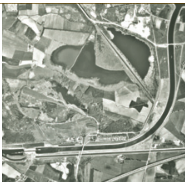
Photographies aériennes du site de Pommerœul en 1977, au cours des travaux de percement du canal et en 1986, après l'achèvement des travaux Photo IGN
