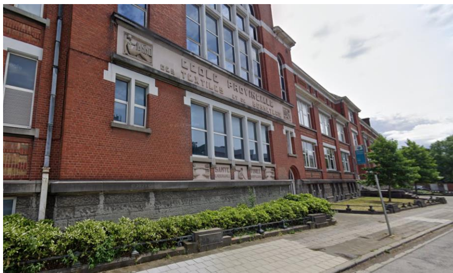
Vue de l'ancienne « Ecole Provinciale des textiles et de bonneteries » à Tournai. C'est dans ces bâtiments que les Ateliers Tournaisiens de Tapisserie du CRECIT sont installés actuellement. Photo : CRECIT
